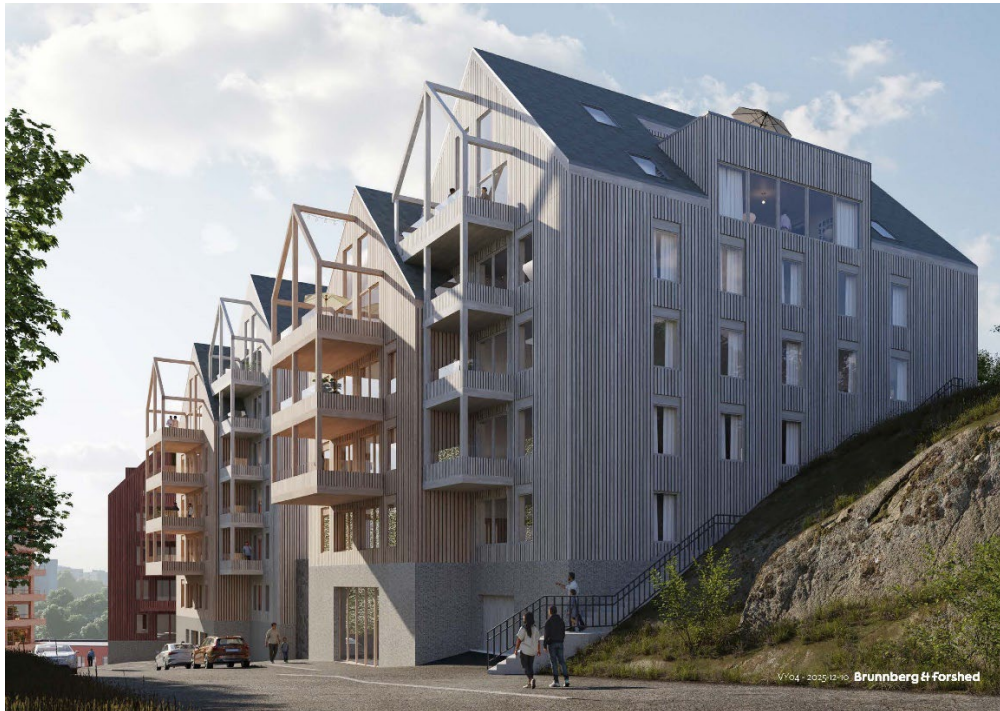
Figur 22. Visionsbild över byggnad H1. Bild: Brunnberg & Forshed, 2025.
